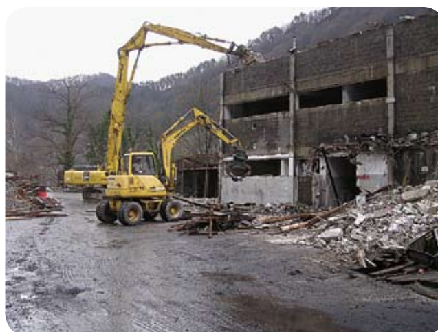
Rušenje objekta SGO
