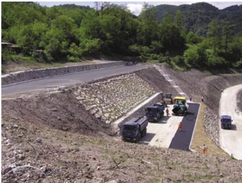
Izgradnja povezave med parkiriščem in cesto Nasipi nad rudnikom Trbovlje potem (foto: Aleš Hočevar)
