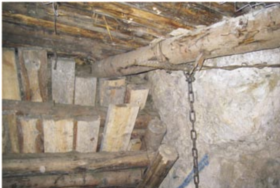
Zavarovanje zruška iz priključne proge v slepi jašek št. 1. (foto: arhiv RTH)
