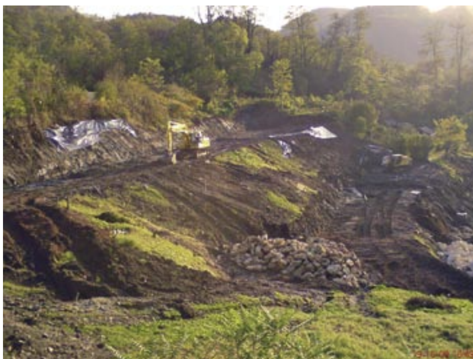
Izgradnja povezave med parkiriščem in cesto Nasipi nad rudnikom Trbovlje prej (foto: Aleš Hočevar)
