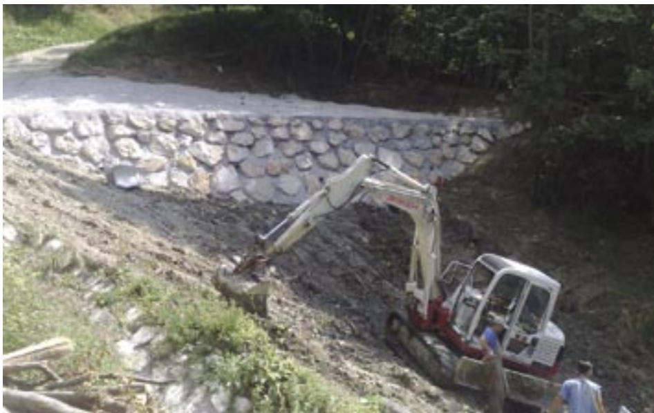
Izdelava podpornega zidu na območju Jesih
