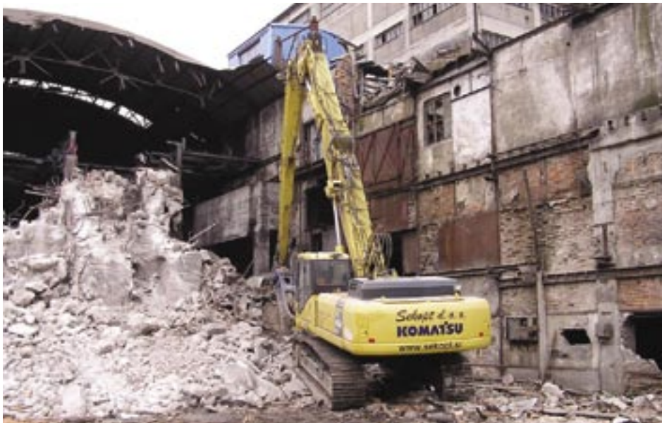
Rušenje stare separacije
