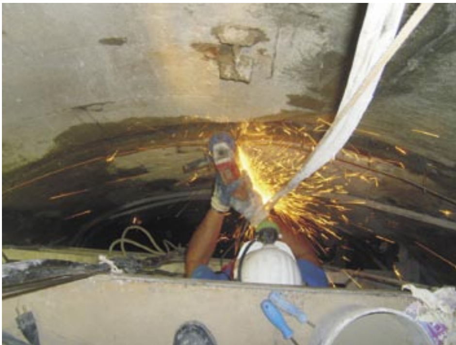
Nameščanje armature za odvodnjevalni kanal
