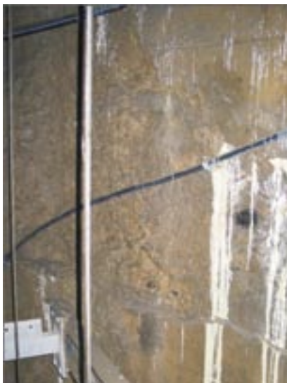
Delamacija (odpadanje plasti betona) betonske površine in »deževje« v jašku pred pričetkom sanacije
