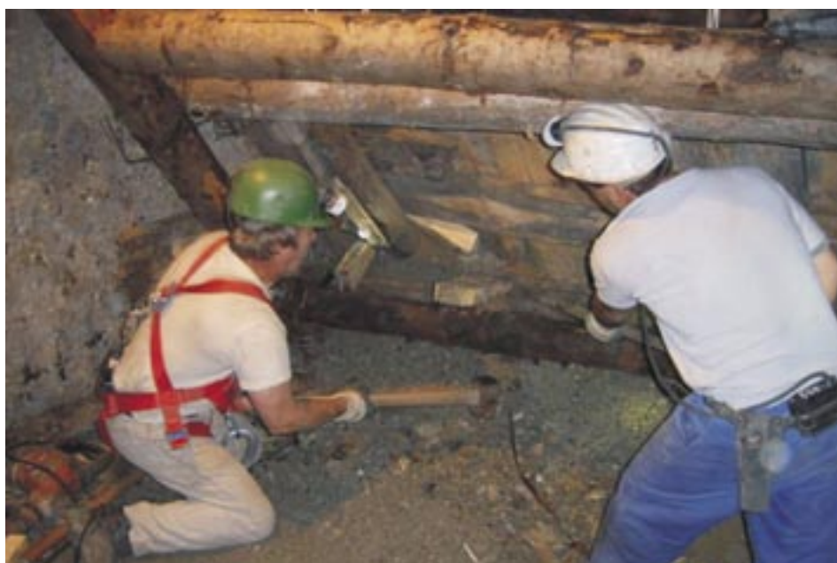
Zavarovanje zruškov z leseno prodirajočo tesarbo v slepem jašku številka 1 (foto: Mitja Pavlič)
