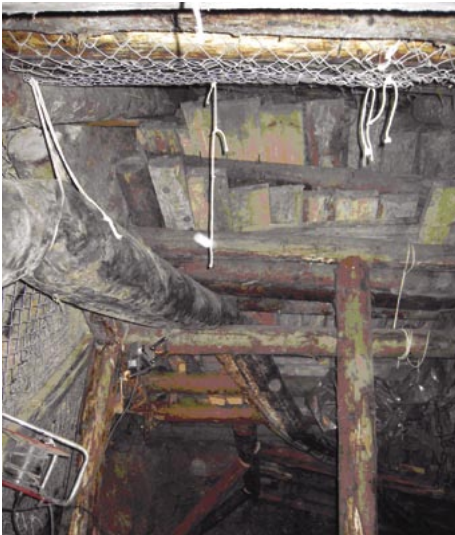
Izvajanje prodirajoče tesarbo (foto: Mitja Pavlič)
